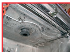
Câmara de enxágue com grande acúmulo de calcário
