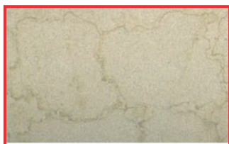
Padrão de manchas causadas por impurezas no vapor condensado
