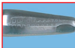
Cabo oco com resíduos visíveis
